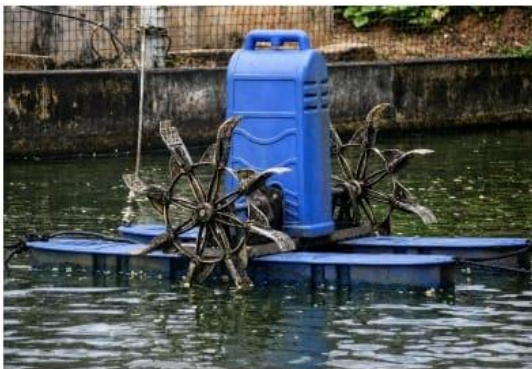
La vasca e il dispositivo di movimentazione richiamano la gestione dell'acqua.
